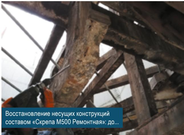
Восстановление несущих конструкций составом «Скрепа М500 Ремонтная»: до...
