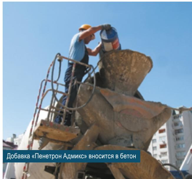
Добавка «Пенетрон Адмикс» вносится в бетон
