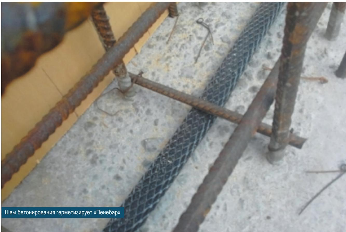
Швы бетонирования герметизирует «Пенебар»
