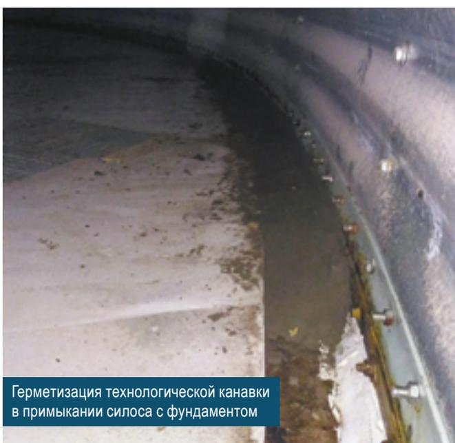
Герметизация технологической канавки в примыкании силоса с фундаментом
