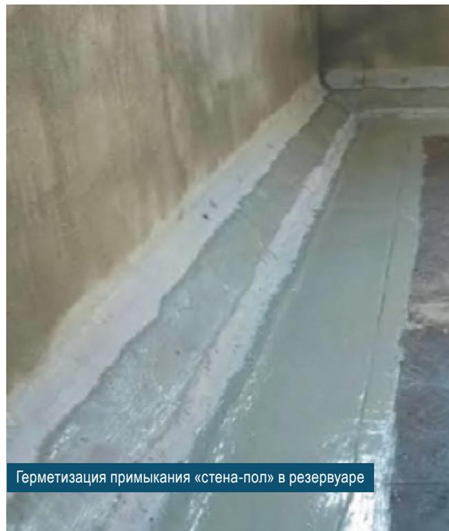
Герметизация примыкания «стена-пол» в резервуаре
